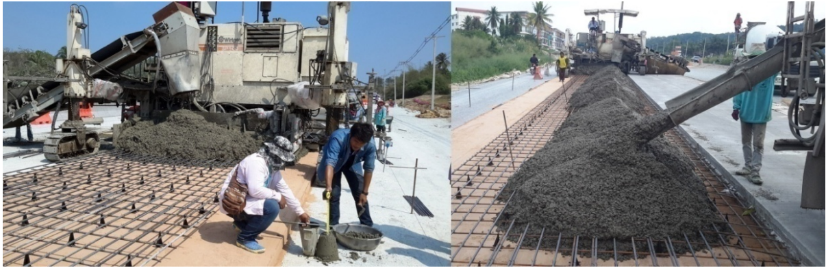
ภาพที่ 19 แสดงการควบคุมคุณภาพคอนกรีตระหว่างก่อสร้าง
