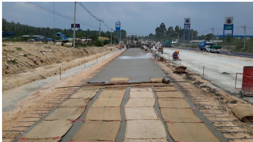
ภาพที่ 22 แสดงการบ่มผิวทางคอนกรีต
