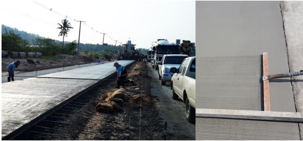
ภาพที่ 21 การกรีตหน้าลายผิวถนนคอนกรีต
