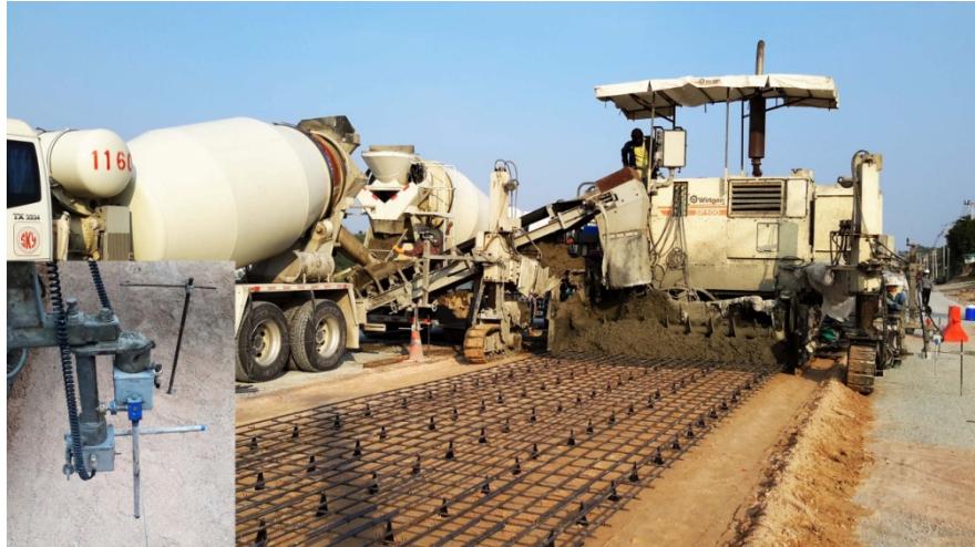
ภาพที่ 15 เครื่องปูถนนคอนกรีต (Slip form Paver) ยี่ห้อ Wirtgen รุ่น SP 500
