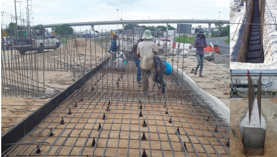
ภาพที่ 30 การก่อสร้างคานคอนกรีตเสริมเหล็ก (Lug Anchor) บริเวณจุดปลายถนน CRCP
