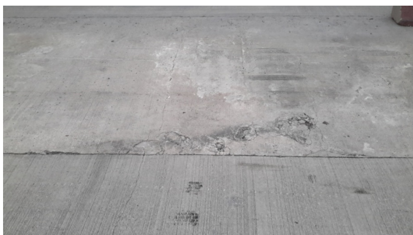
ภาพที่ 36 ผิวหลุดร่อนเมื่อเปิดใช้งาน และเกิดการแยกตัวของคอนกรีต
