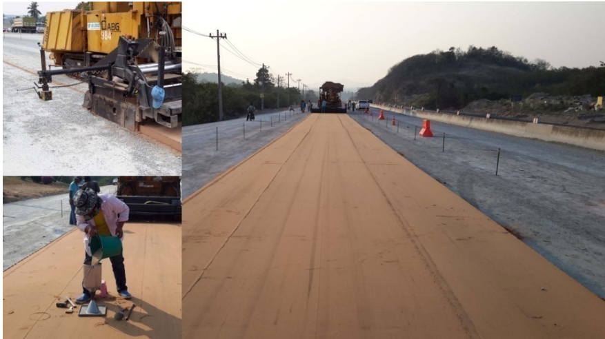
ภาพที่ 16 แสดงการเตรียมชั้นทรายรองถนนคอนกรีต (Sand Cushion)
