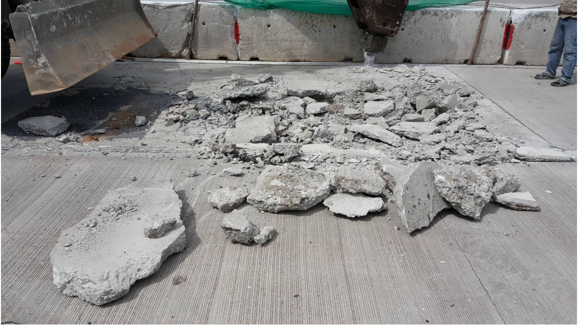
ภาพที่ 37.2 การซ่อมแซมรอยแตกถนน CRCP โดยการทุบรื้อก่อสร้างใหม่
