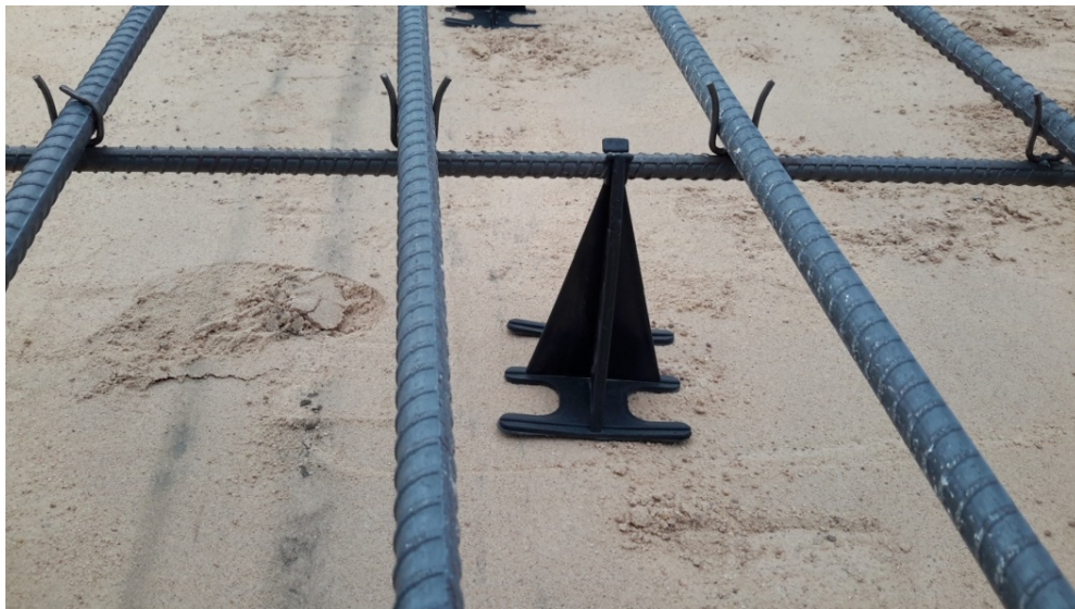
ภาพที่ 13 แสดงตัวอย่างการติดตั้ง Bar Chair ที่ใช้ในโครงการฯ
