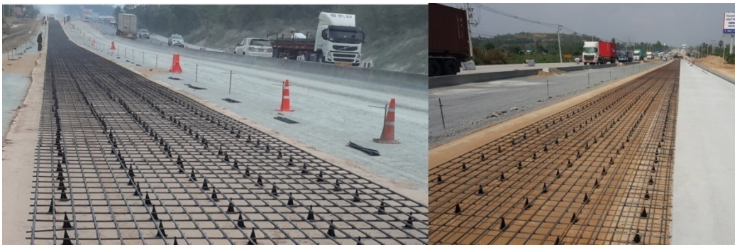
ภาพที่ 18 แสดงการวางเหล็กเสริมตามยาวก่อนเทคอนกรีต
