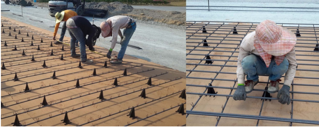
ภาพที่ 17 แสดงการติดตั้ง Bar Chair กับเหล็กเสริมตามขวาง
